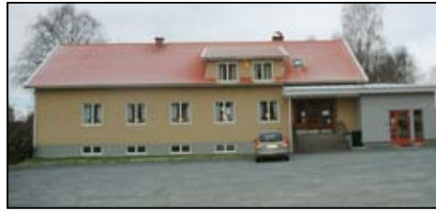
d) Församlingshemmet från 1959 samt detalj av entrétrappa.
